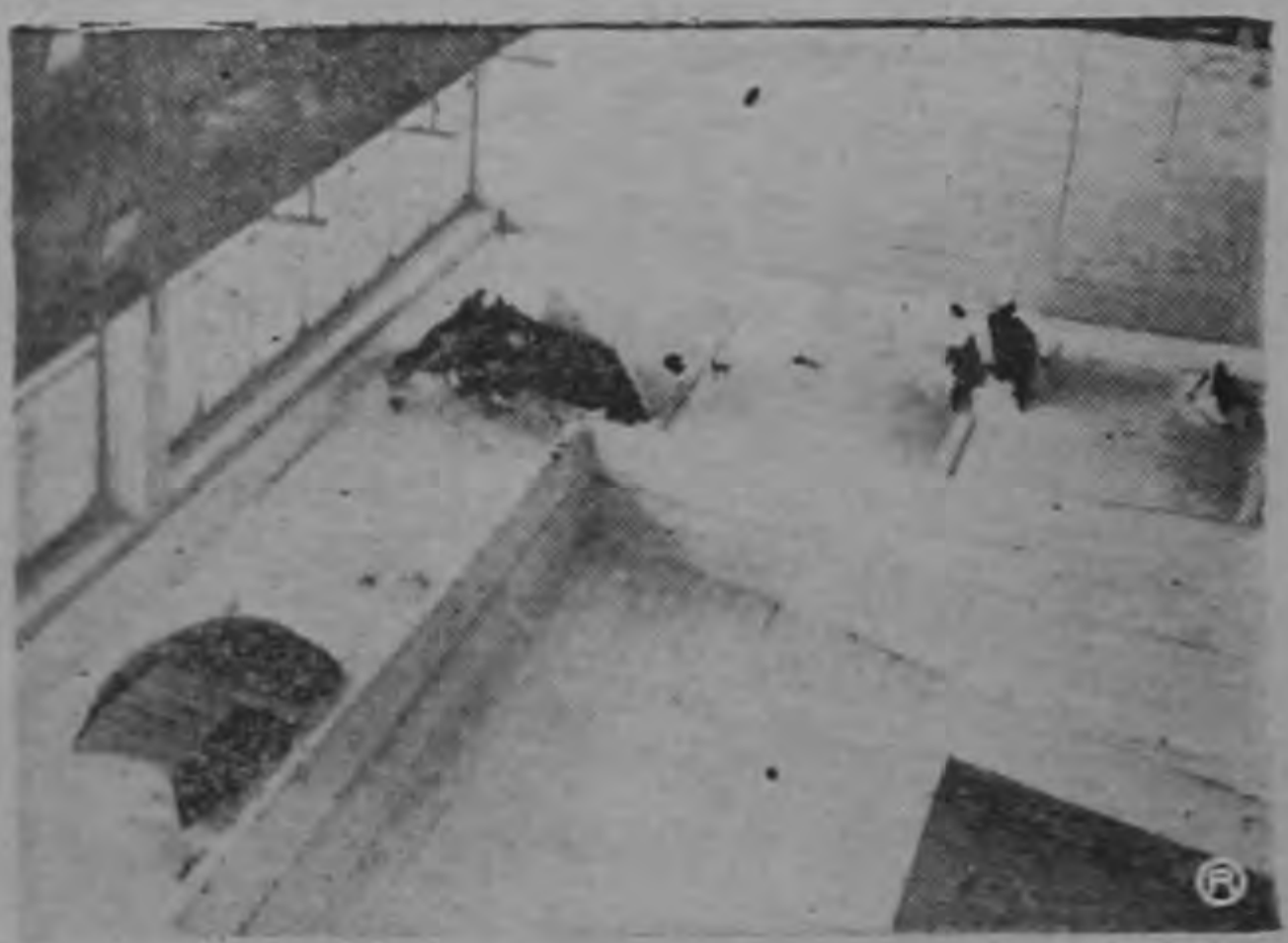
EN DETERIORO EL EDIFICIO DE LOS ARCHIVOS.— El Edificio de los Archivos Nacionales se encuentra en lamentable estado. La foto deja apreciar parte del cielo raso, donde la lluvia y el sol invaden sin composición los documentos. Se busca una nueva ubicación para esta importante entidad. (Foto SOLANO)
